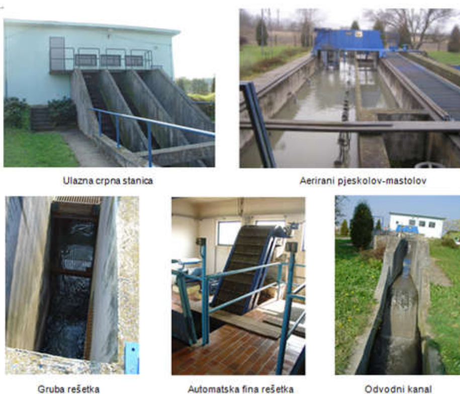
Slika 2.1.2-2. Objekti postojećeg UPOV-a
